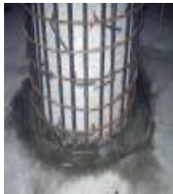
Fig.4. a) Këmishë betoni
